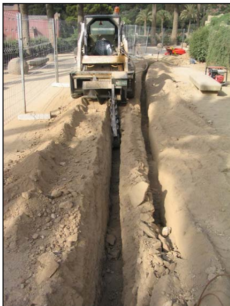
FOTO 11. Doblament de la rasa a la Zona Monumental amb rasadora
