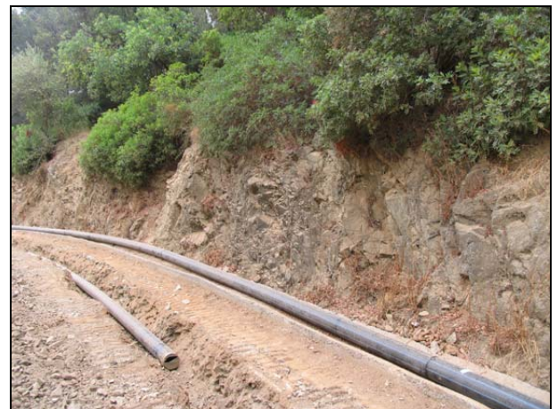
FOTO 4. Rasa a la zona forestal. S'aprecia el retall al pendent en obrir el camí
